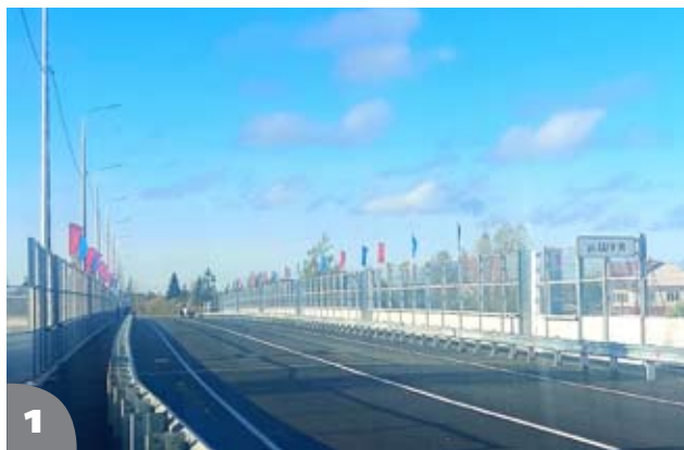
1 Отремонтировали мост через реку Шуя.
