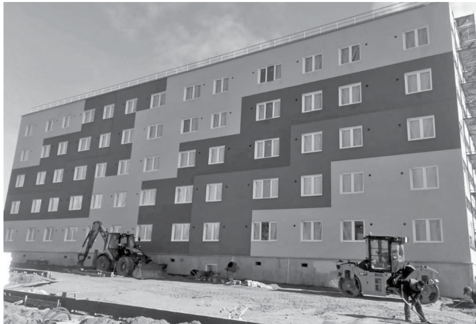
Строящийся дом для переселенцев в Пиндушах
