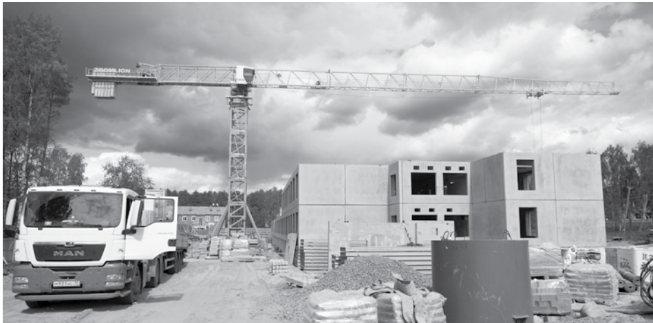
Строительная площадка школы в Суоярви. Фото: «Республика»/Сергей Юдин
