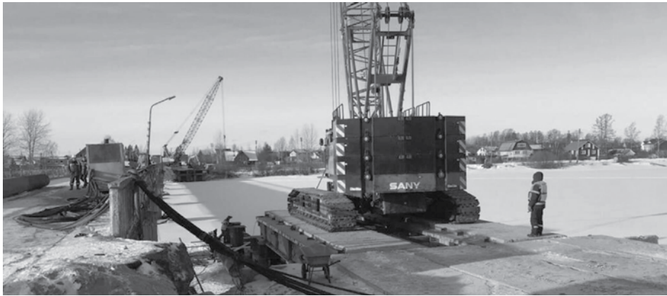
Реконструкция Шуйского моста. Фото: Минтранс РК
