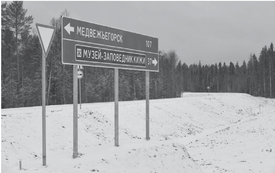
Отремонтированный участок трассы. Фото Сергея Юдина
