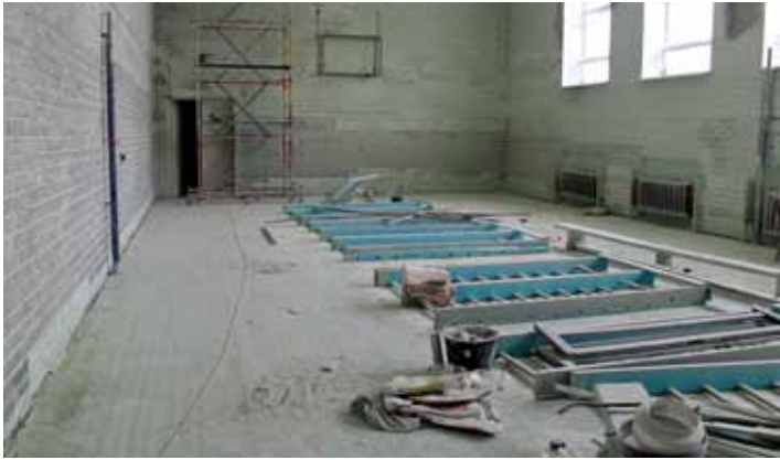
Ремонт спортзала в школе п. Мелиоративный
