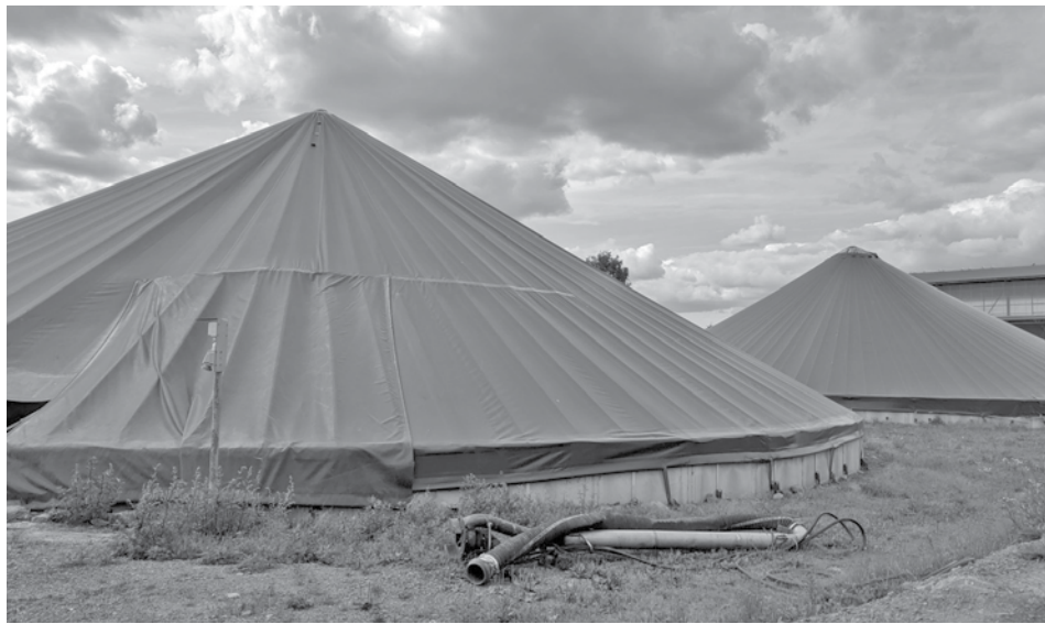
Территория мусороперерабатывающего комплекса в Китеэ
