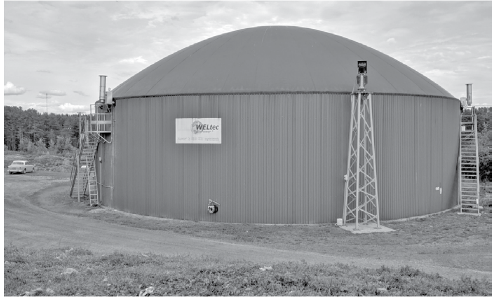
Биогазовая станция BioKymppi Oy в Китеэ
