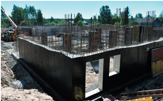
Строительство школы в поселке Деревяннка
